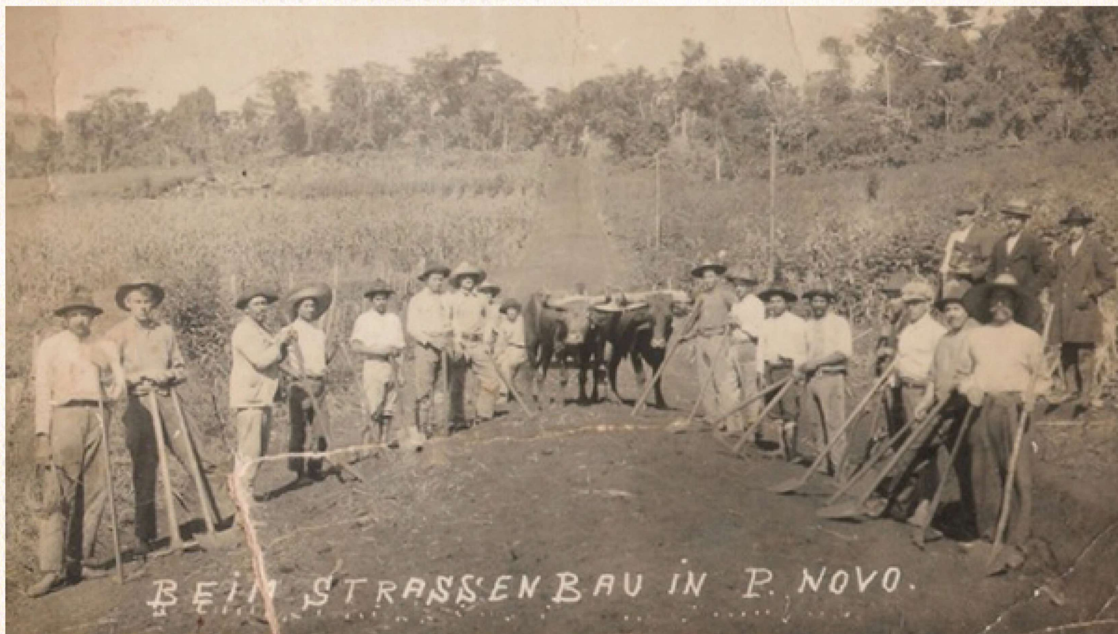
Construção de estradas em forma de mutirão.
